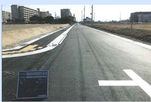
区画道路築造及び舗装工事を実施しました。 第18期～第28期区画道路築造・舗装工事等
