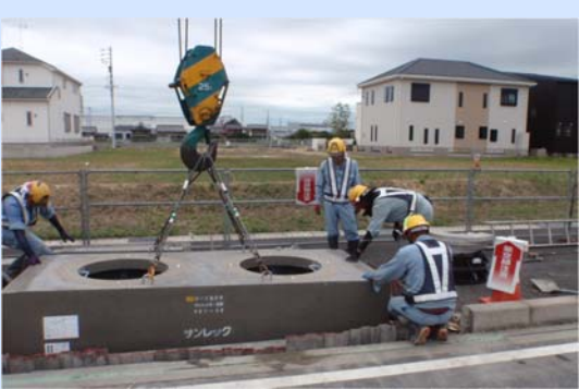
電線共同溝設置工事を実施しました。 電線共同溝設置工事(その3)、(その4)、(その5) 電線共同溝設置に伴う設備工事(E-30、T-30)
